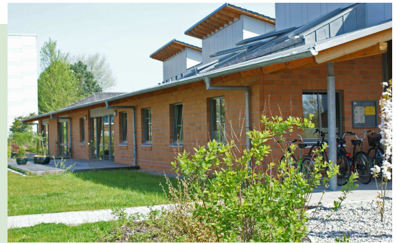
Renoviert: Die Tagesklinik in Husum
