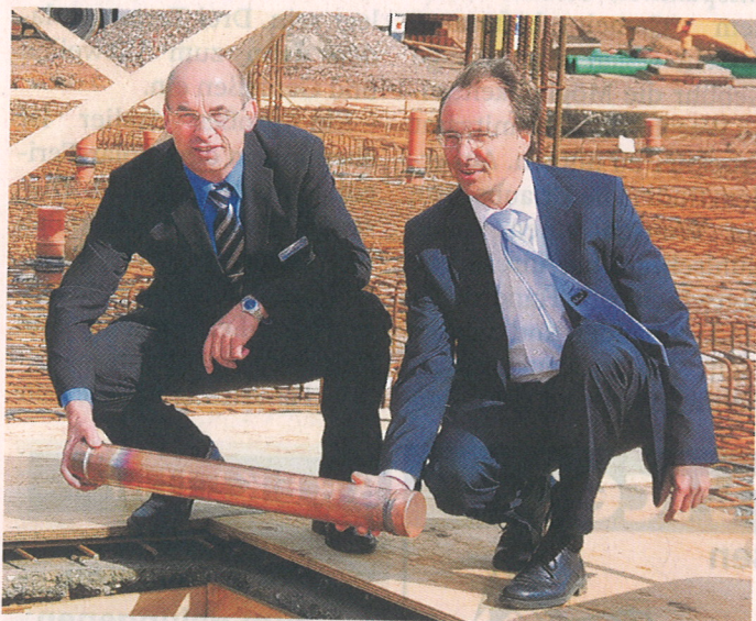
Bei der Grundsteinlegung für ein wegweisendes Bauprojekt der Fachkliniken Nordfriesland: Geschäftsführer Ingo Tüchsen (links) und Chefarzt Christoph May.
