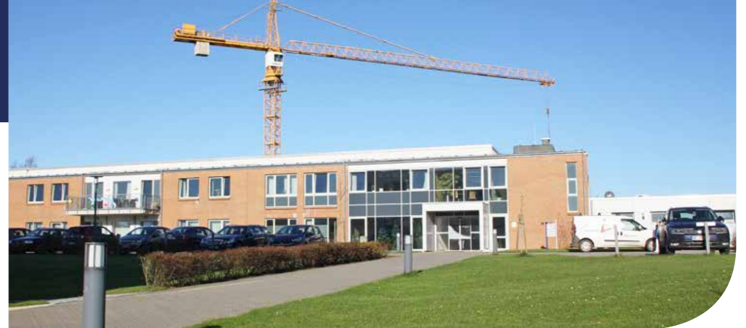
Erfüllt steigenden Bedarf: Neben einer Erweiterung auf zukünftig 120 Therapieplätze (bisher 80) entstehen hier auch Arbeitsplätze: Die DIAKO Fachklinik für Rehabilitation in Breklum wächst. Fotos: Bauer
