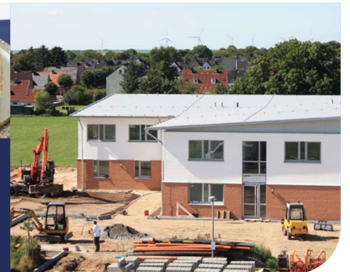
Hier entsteht das Verwaltungsgebäude (A01)
