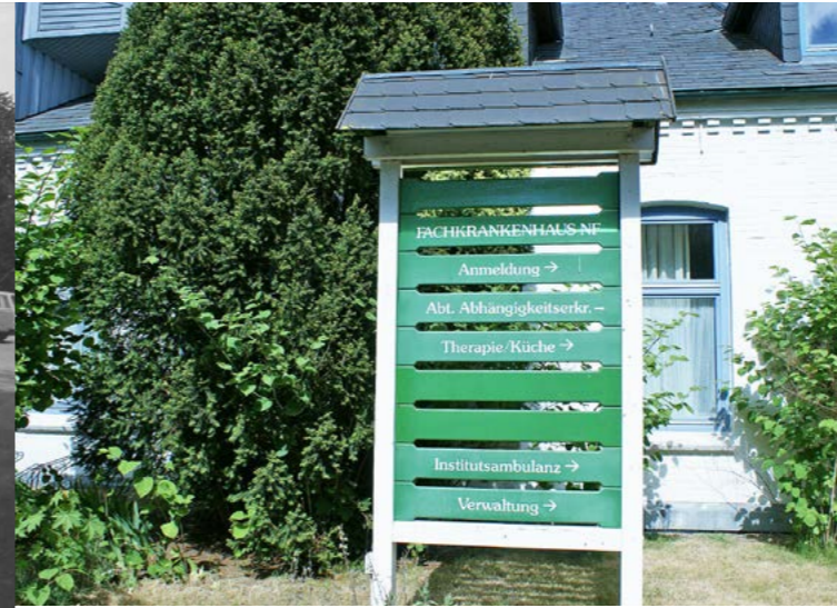
Bis 2000: Erweiterung der Angebote um die Rehabilitation und die Abteilung für Psychosomatik in Bredstedt, Krankenhausweg.
