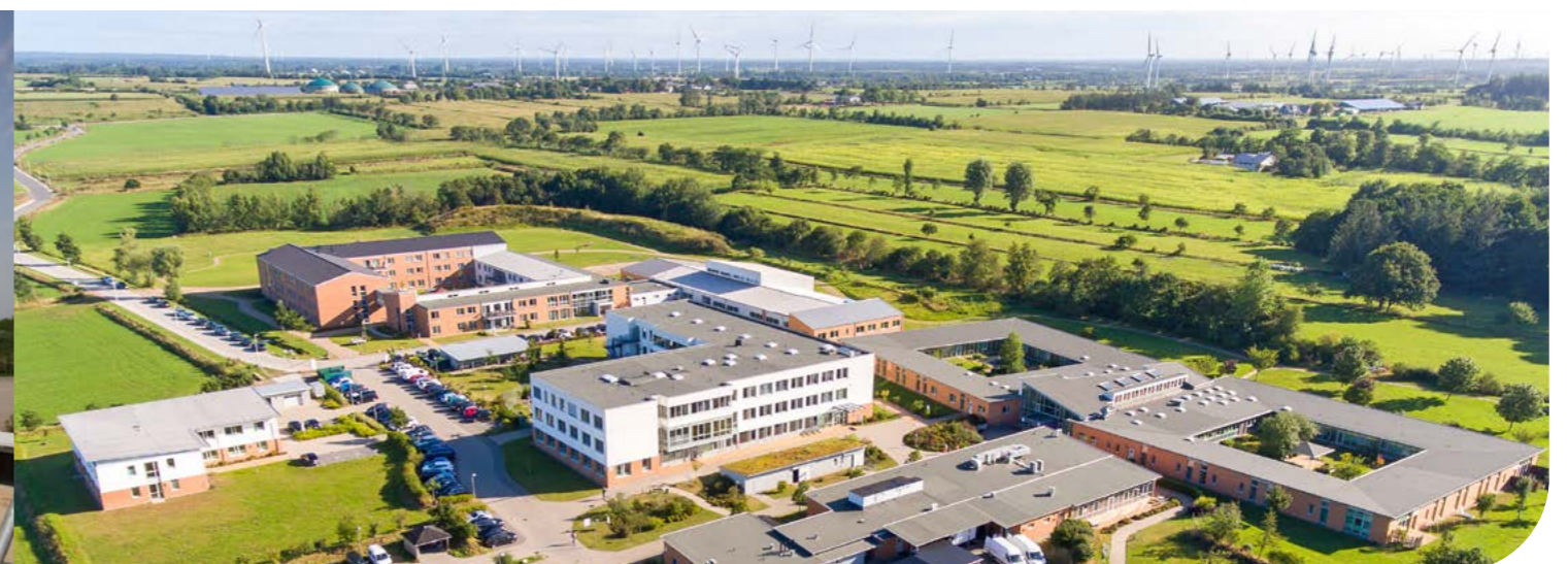
Stand 2020: Klinik-Standort Breklum-Riddorf mit den Erweiterungsbauten der Rehabilitation
