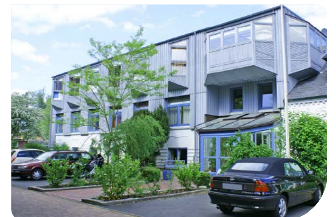
Haupthaus des Fachkrankenhauses Nordfriesland im Krankenhausweg im Jahr 2007 (Heute: Hans Christian Nickelsen Haus)
