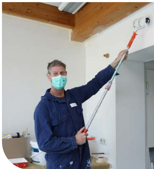
Die Ergotherapie in der TKE Flensburg nutzt die Zeit für Renovierungsarbeiten.
