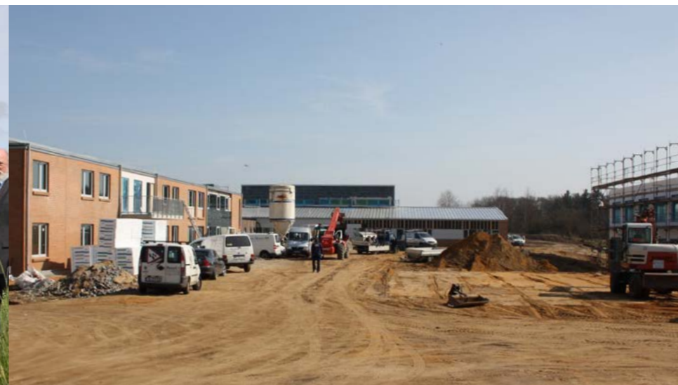
2012: Bauphase für die Gebäude Ao2- Ao4 und Ao7
