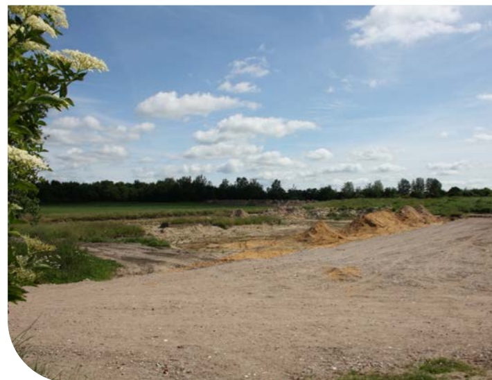
2011: Bauvorbereitungen in Breklum-Riddorf u.a. für die Allgemeinpsychiatrie, Entzugsstation und Rehabilitation (Ao2-Ao4, Ao7)
